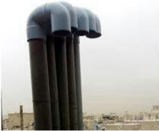
شکل ۵- ۲۱: لوله هواکش
