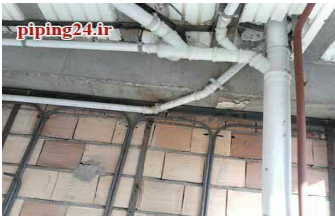
شکل ۵-۲۳: طریقه انشعاب‌گیری در لوله‌کشی زیر سقفی فاضلاب
