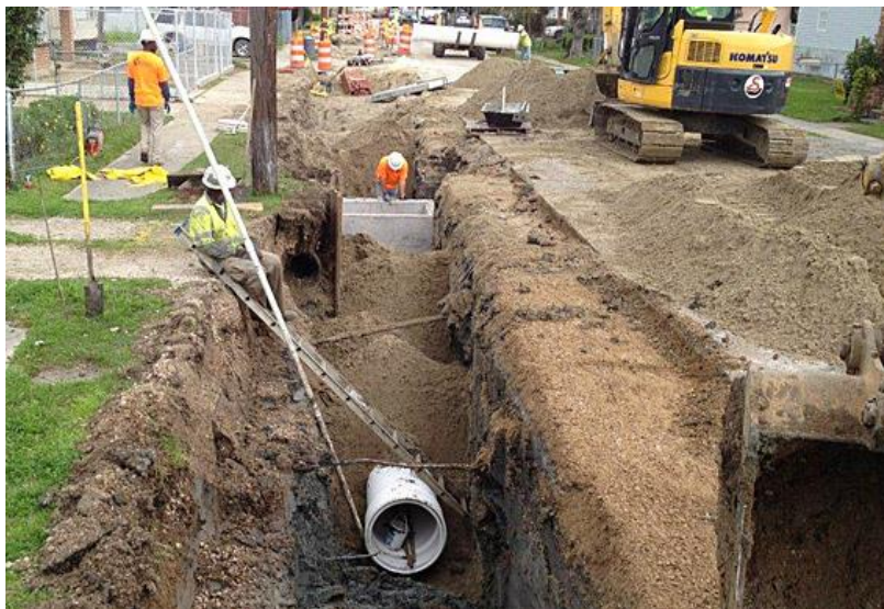
شکل ۵-۳: خاکریزی و پر کردن ترانشه
