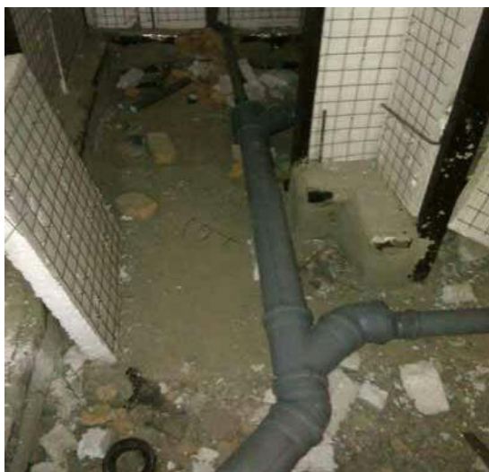
شکل ۵-۲۲: لوله‌کشی فاضلاب بصورت کف خواب
