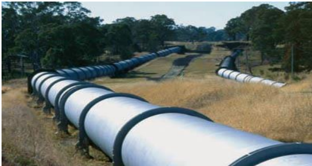
شکل ۵-۷: نصب لوله‌های یوپی‌وی‌سی در سطح زمین
