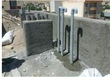
شکل ۵- ۲۱: لوله هواکش
