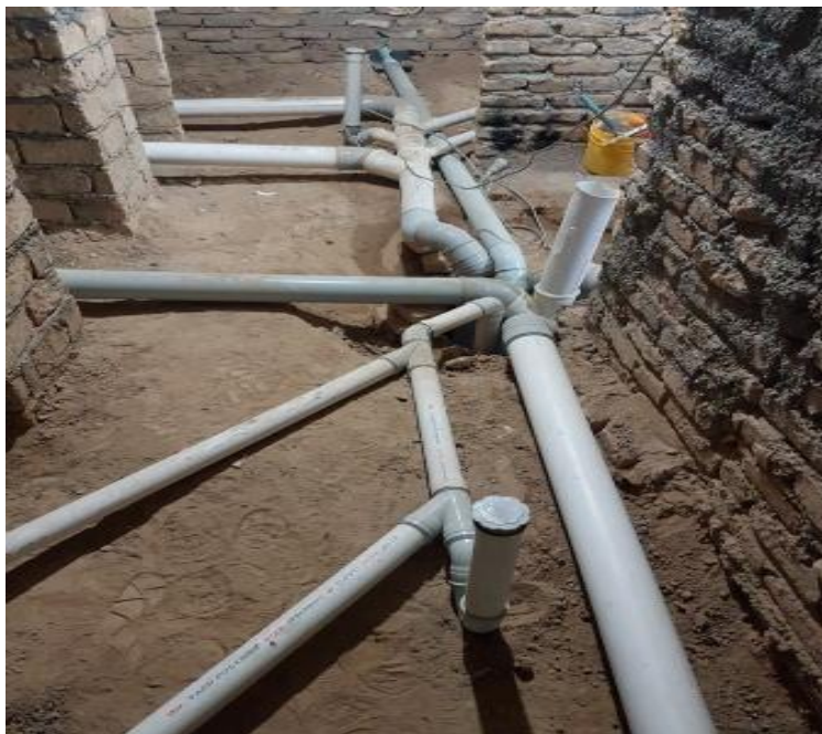
شکل ۵- ۲۰: لوله‌کشی فاضلاب بهداشتی ساختمان (اجرا از کف)
