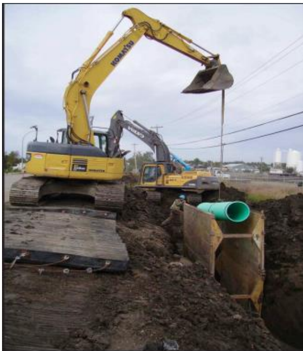
شکل ۵-۲: نمونه‌ای از لوله‌گذاری لوله‌های پوپی‌وی‌سی
